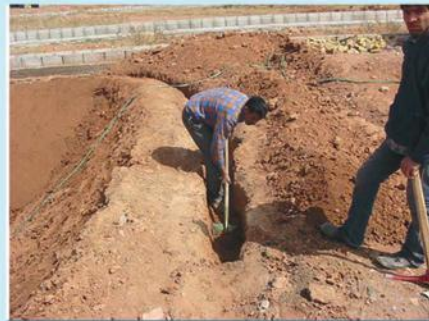
مفر ترانشه جهت مهار کردن ورق در محیط استخر
