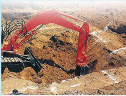
کود برداری بعد از تراز کردن سطح و کف استخر
