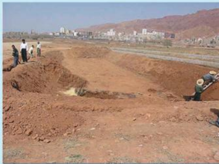
کشیدن گاه کل در مناطقی که بستر مشکل تیز گوشه یا ریزش باشد
