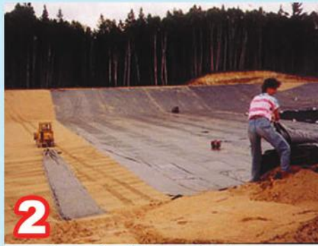
پیدمان ورق جهت جوش و نصب ورق
