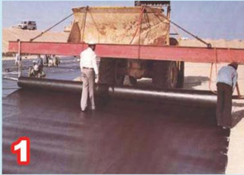
پهن کردن ورق بصورت دستی و ماشینی
