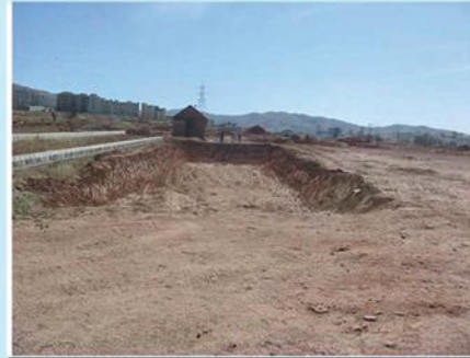
بستر کود برداری شده قبل از دادن تراکم به دیواره ها و کف
