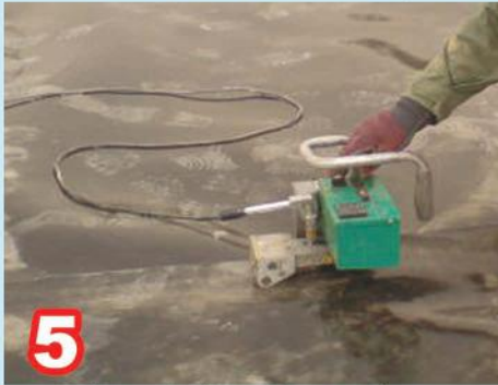
جوش ورق بوسیله دستگاه های دیجیتالی
