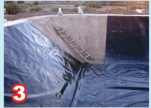
نمونه برش و قرارگیری ورق درکنج
